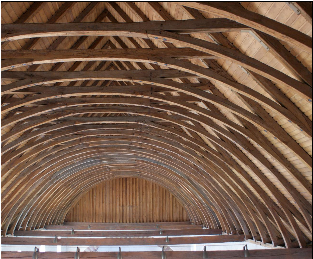
Reichenau-Niederzell, Klosterkirche. Hochschiffdach, 1234 (d). Foto: Burghard Lohrum
